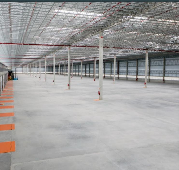
**RETRAX A1** é um aditivo compensador de retração para concretos e argamassas à base de cimento tipo Portland. Formulado com óxidos e compósitos minerais de granulometria controlada, sua principal função é controlar a retração do concreto e eliminar as fissuras de retração por secagem na fase inicial. **RETRAX A1** limita também a retração a longo prazo, melhorando a resistência do concreto à compressão e a tração, reduzindo a permeabilidade e aumentando a durabilidade das estruturas.
